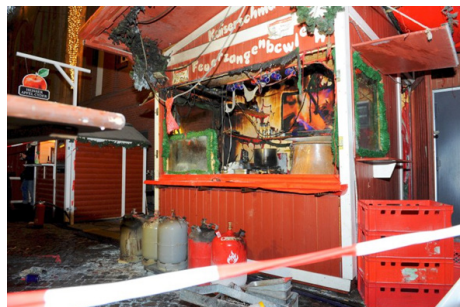
Abb. 10: Weihnachtsmarktstand nach Verpuffung bei Gasflaschenwechsel
