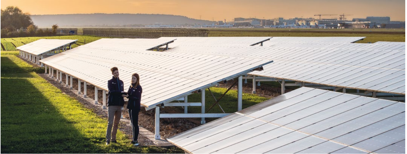
In seiner Klimastrategie STRzero sieht der Flughafen vor, seine Energieerzeugung auf regenerative Quellen umzustellen. Bis zu 30 PV-Anlagen will er dafür auf Freiflächen und Gebäuden installieren.
